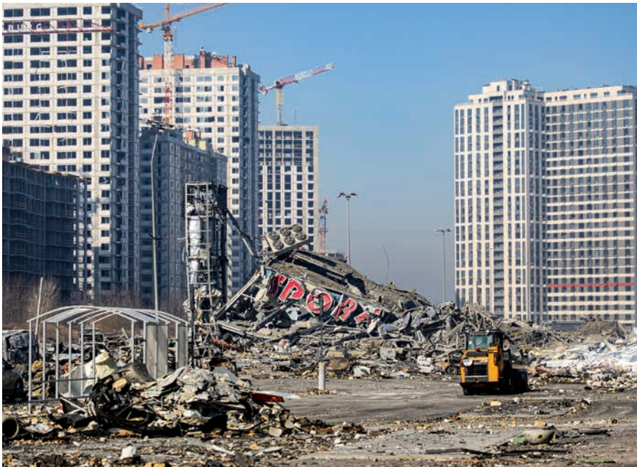
Von einem russischen Raketenangriff zerstörtes Einkaufszentrum in Kiew.
