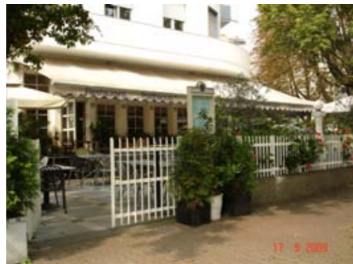
Anforderungen der Vorgartensatzung wurden eingehalten. Lediglich ein- oder ausfahrbare Markise ohne Stützkonstruktion
