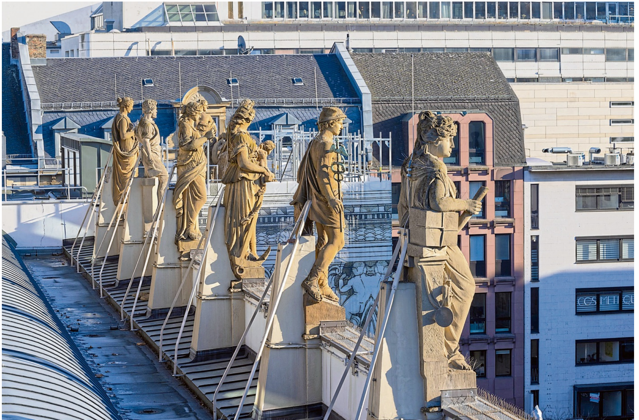
Tradition und Klimaschutz: Auf dem Dach des IHK-Gebäudes soll nun auch eine Photovoltaikanlage Platz finden.
